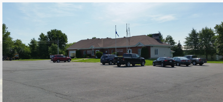
Terrain de stationnement en marge avant
