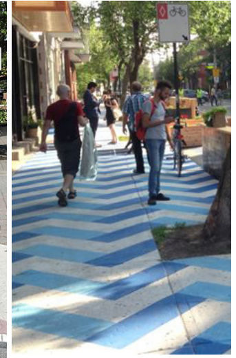
Marquage sur trottoir d'asphalte - Solution transitoire
